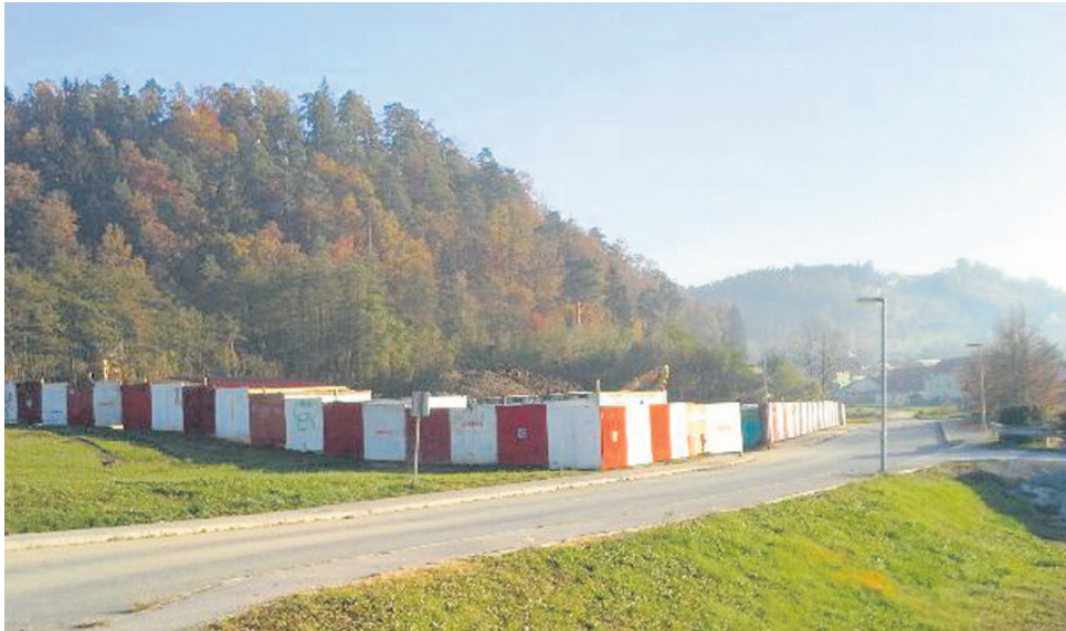
Oživiljanje stanovanjske gradnje. Gradbišče v Mozirju, kjer gradijo nov blok.
