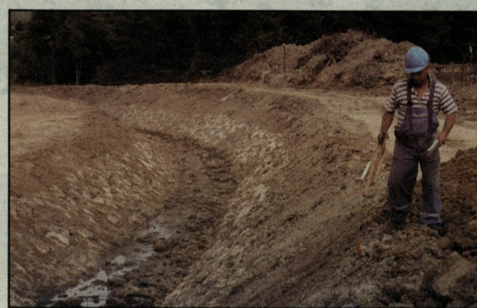
Med prestavitvijo dela vodotoka
