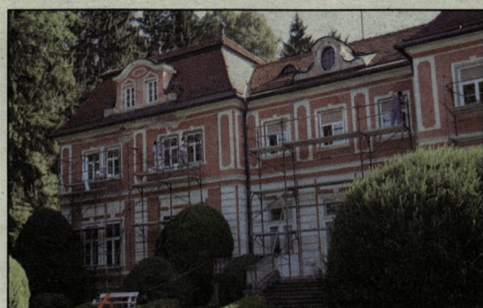
Zamenjava stavbnega pohištva v graščini
