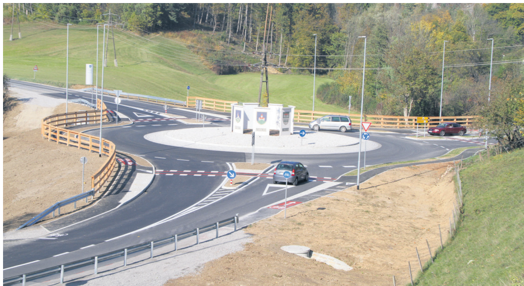
Gradnja je bila zahteven gradbeni projekt, vreden približno milijon evrov, ki je poleg gradnje krožišča zahteval še kar nekaj spremljajočih gradbenih posegov, kot sta gradnja mostu in premestitev bližnjega kozolca. Med grbi raste lipa. (Foto: Benjamin Kanjir)
