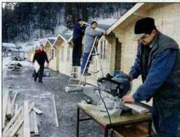
Ob novi skakalnici na Gorenji Savi že potekajo zaključna dela pri montaži ogrevalnih hišk in stolpu. / Foto: Gorazd Kavčič
