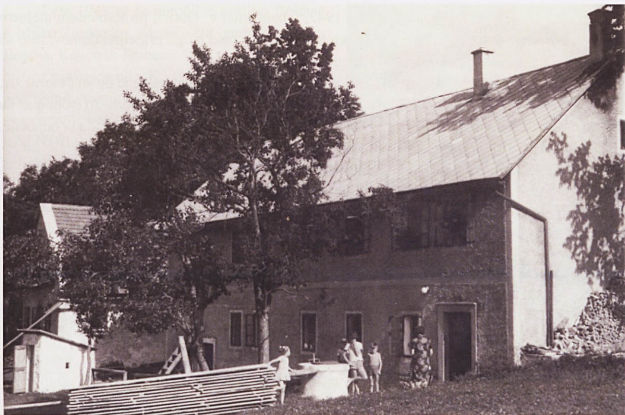
Obnovljena Bjokna hiša med pripravo lesa za ostrežje hiše.
