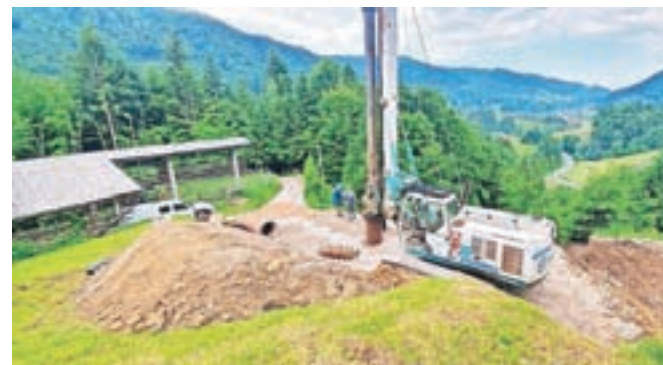
Zahtevna gradbena dela v Špitaliču / FOTO: OBČINA KAMNIK
