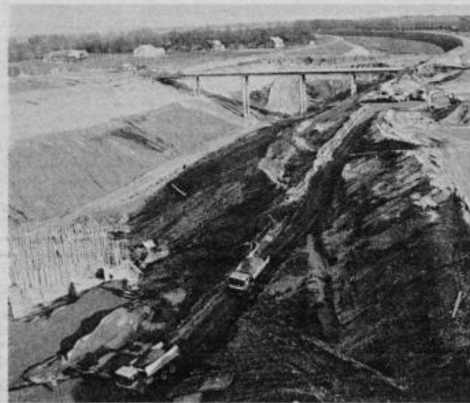
Gradnja odvodnega kanala HC Formin.
