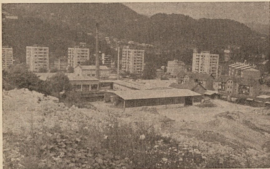
Opekarna TOZD Gramat DO RGD, v ozadju pa stanovanjske stolpnice, ki so bile zgrajene v zadnjih letih za potrebe organizacij združenega dela in njihovih sodelavcev.
