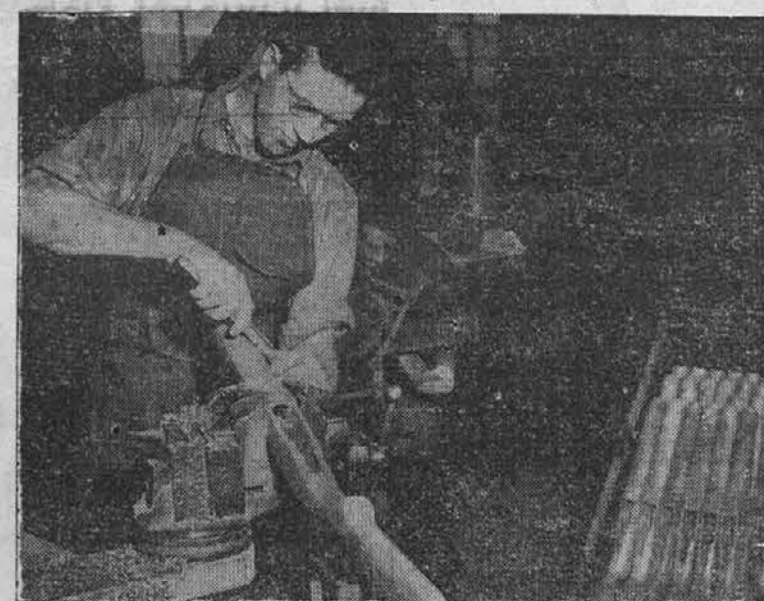
Na sliki vidimo nekega delavca, ki izdeluje v tovarni kopta za vojaške puške.
