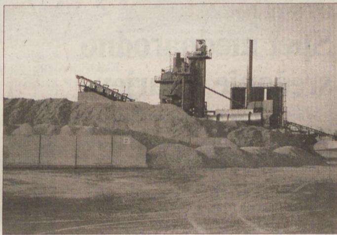
Priprave na veliki projekt gradnje avtoceste v Pomurju: s kakšnim gramozom?
