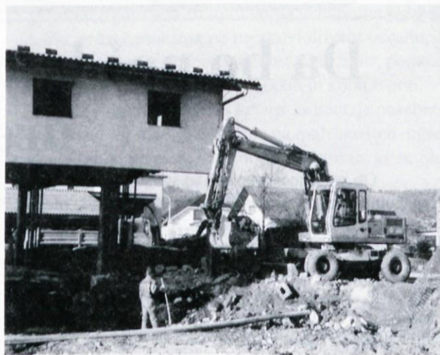
Na Mavričnem gradbišču.
