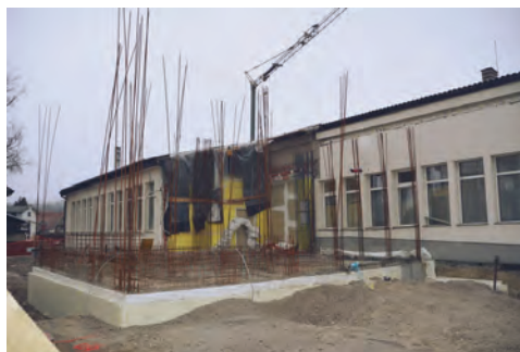
Gradnja prizidka pri zdravstvenem domu.
