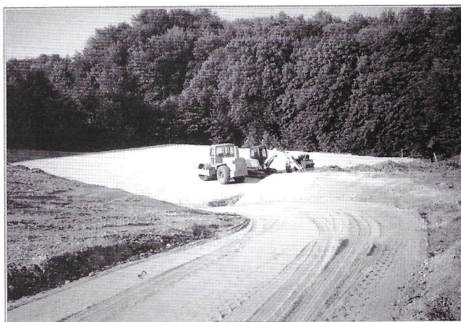
Na sliki zgrajeni plato za asfaltiranje igrišča.
