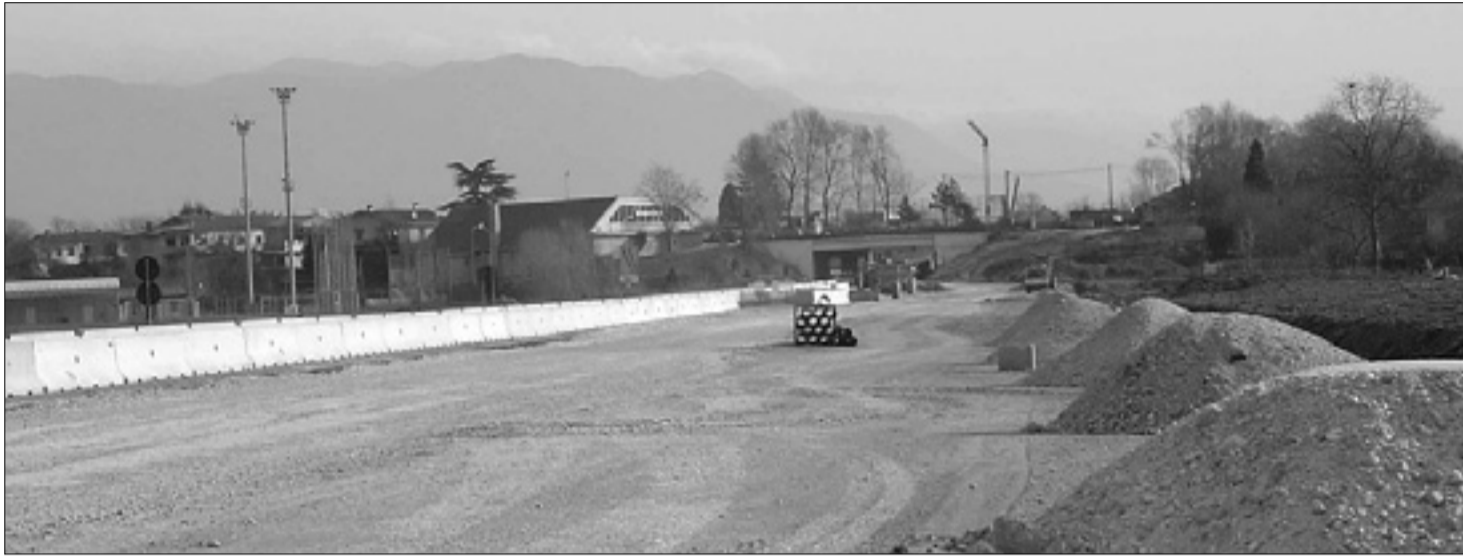
Gradbišče avtoceste v Sovodnjah
