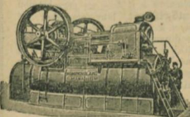
**Amtliches Prüfungsattest**, vorgenommen an einer **100 P. S. Heißdampf-Compound-Lokomobile** mit Kondensation und **Ventilsteuerung System „Lentz“**:
