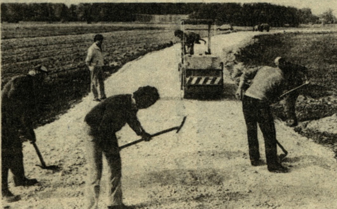
Gradnja ceste Zgornje Grušovlje — Zalog
