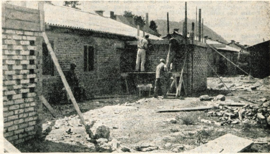
Provizoriji, ki jih gradi Komunalni servis Kranj na Planini za stanovalce Podrtine, ki se bodo morali izseliti zaradi gradnje mostu čez Kokro, bodo v kratkem popolnoma dograjeni, verjetno že do 15. junija. Gradbena dela so že končana, le pobeliti jih morajo in še preplekati okna in vrata. V štirih provizorijih bo 16 solidnih stanovanj. Ko bodo ta dograjena, bodo stanovalce takoj vselili, Podrtino podrl in nato takoj pričeli z gradnjo mostu
