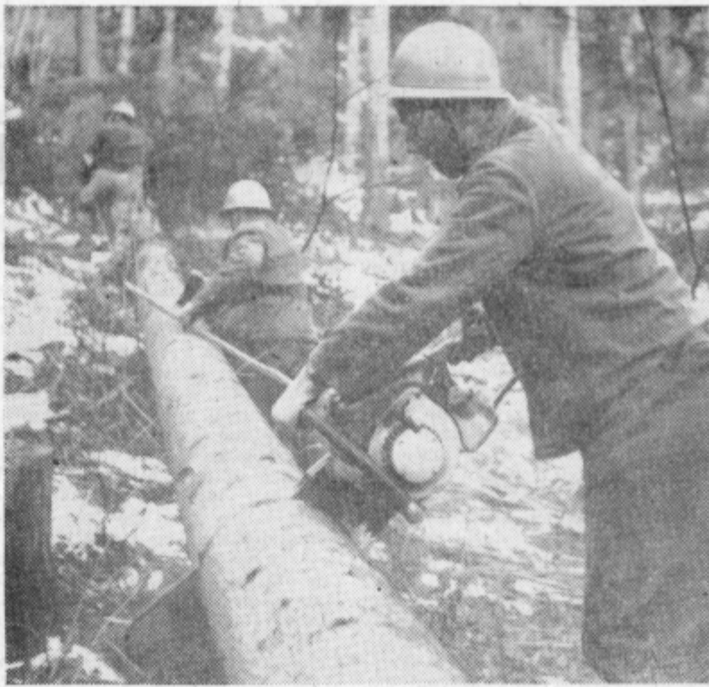
Motorna žaga s predirljivim krikom moti gozdno tišino in orjak že zgrmi na tla. Delavci v čeladah v kratkem času razrežejo orjaška debela.
