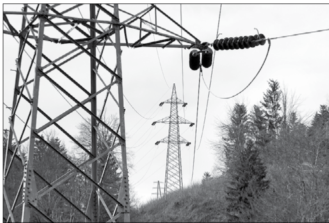
Trasa kablovoda je dolga dobrih enajst kilometrov. V zemljo se bodo položili trije sistemi glavnega voda. (Foto: IS)
