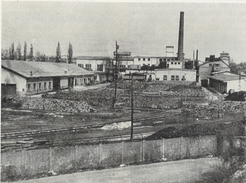
Pred slabima dvema letoma je bil tu urejen lesni prostor. Zdaj stoji na desni strani remontnih delavnic nova toplotna, na levi pa je veliko gradbišče V. PS (Foto: C. Zupančič)
