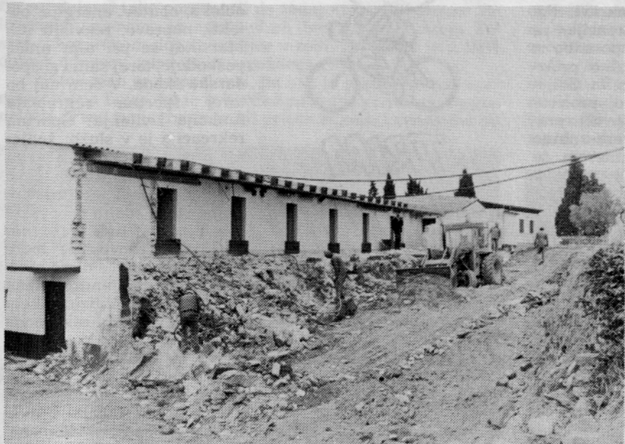
Plan popravila je narekoval odkop terena za spalnim traktom zaradi izsušitve spodnjih sob
