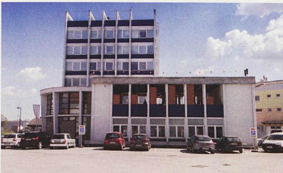
Prenova prizidka upravne stavbe na trati
