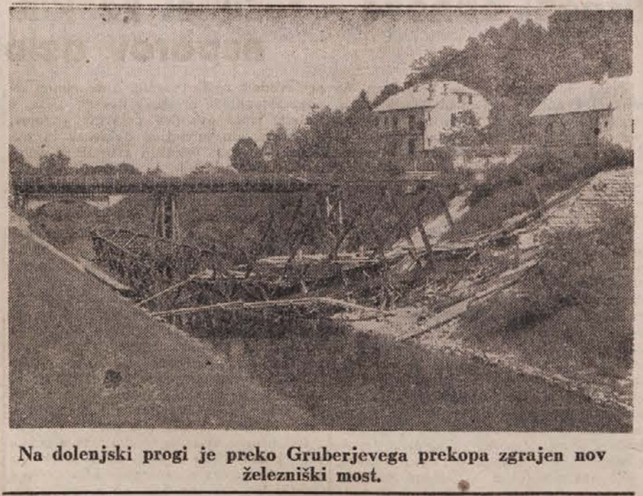
Na dolnjski progji je preko Gruberjevega prekopa zgrajen nov železniški most.
