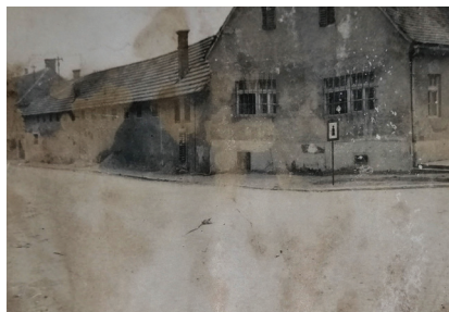
Stare zgradbe ob jedru naselja, kjer je programsko predvidena avtobusna postaja.
