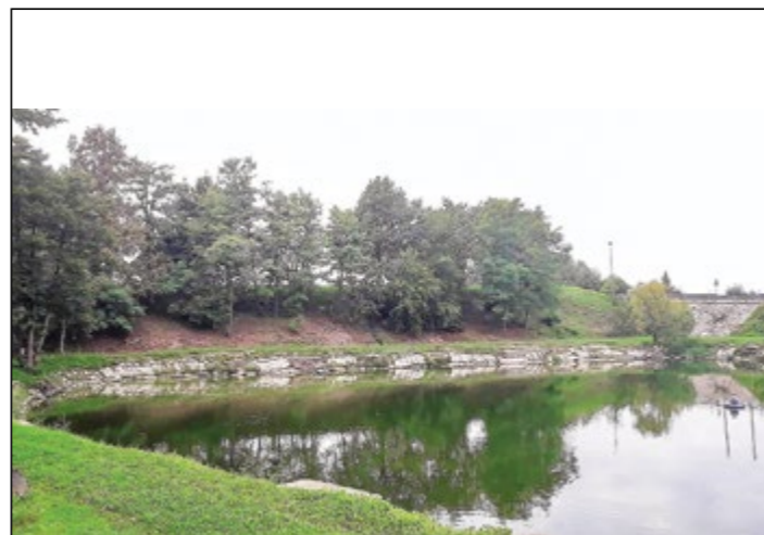
Okrog obale draženskega ribnika je položen beton.
