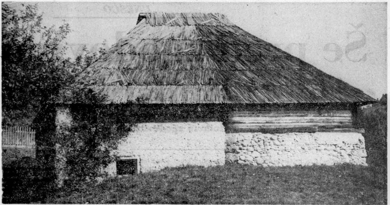
KOROŠKA ZIDANICA Izvolastniška, dvojna, štirikapna zidanica »kleta« iz nekdanjega vinogradniškega področja okoli Zitare vasi, kjer je vinogradništvo zamrlo okoli leta 1925
