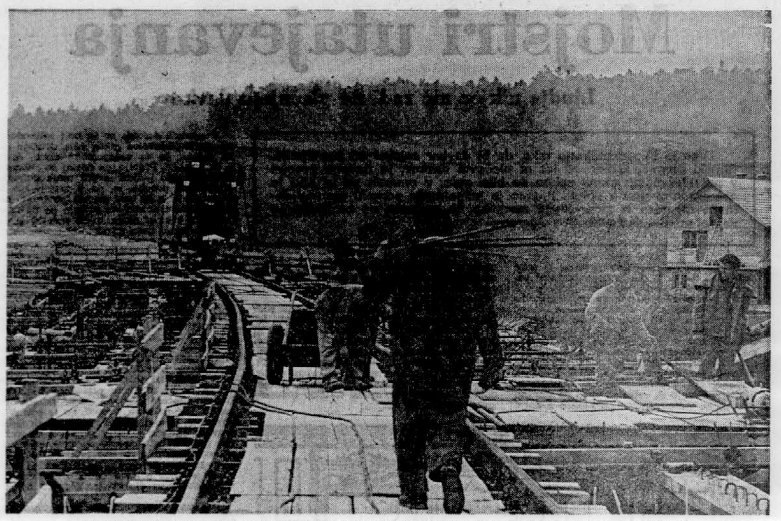
E. SELHAUS: VIADUKT PRI IVANJEM SELU NA BODOČI AVTOCESTI VRHNIKA—POSTOJNA
