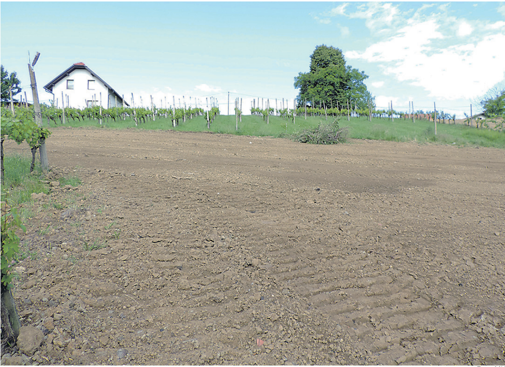
Sanacijska dela na plazu so pri koncu.
