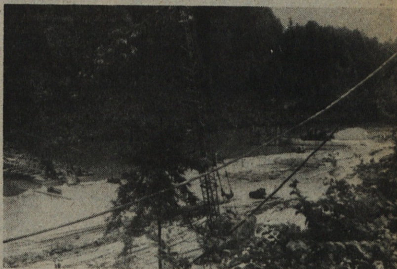
Pogled na gradbišče HE Mavčiče
