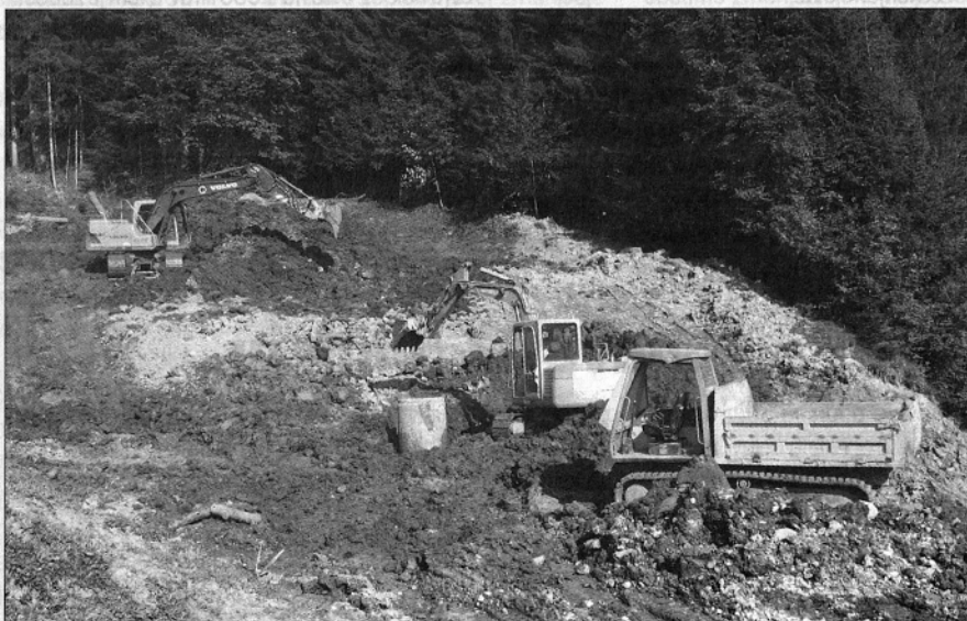
Ureditev plazu je izvedlo gradbeno podjetje Pirc (foto: Marija Lebar)
