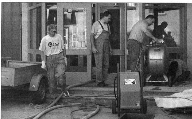
Obnova kanalizacije v počitniških dneh (foto: Marija Lebar)
