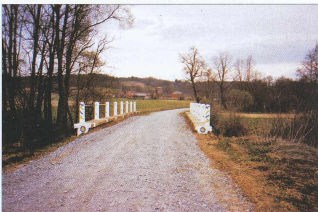
Stanje po obnovi
