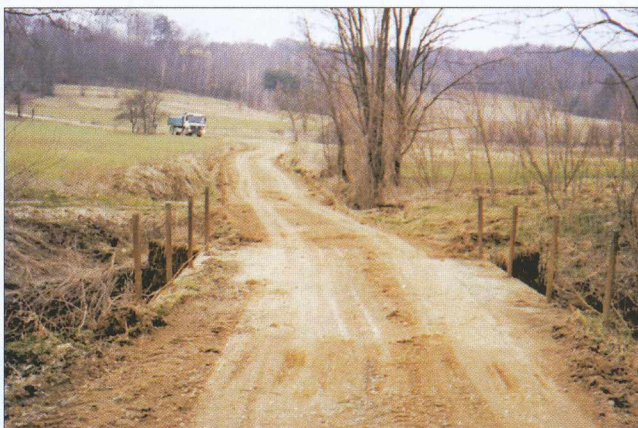
Obnova ceste in mostu
