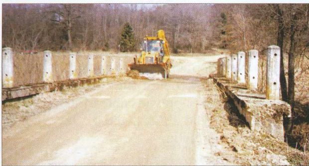
Most v času sanacije
