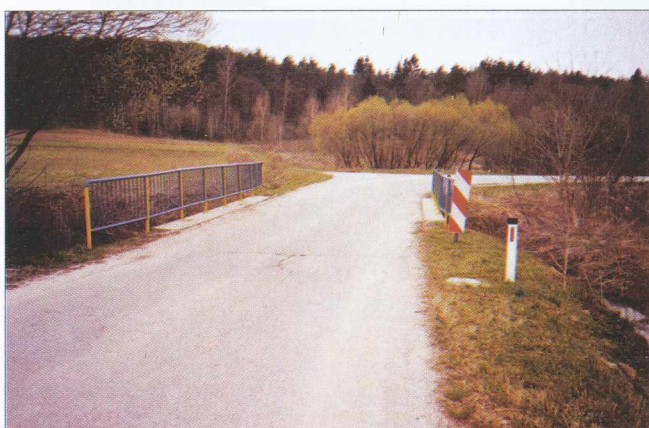
Prebarvan in urejen most na cesti Boreča-Šulinci
