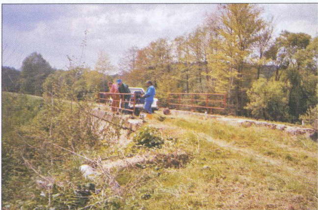
Izdelava ograje na mostu
