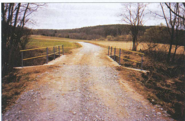
Stanje po obnovi
