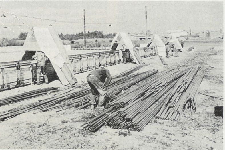
Nad 18 km cevi bo vgrajenih na novem umetnem drsalšču pri Hladnici v Zalogu. Žal pa igrišče v letošnji sezoni ne bo nared, ker čas za betoniranje zgornje plošče v pozni jeseni zaradi zmrzovanja ni primeren. Na sliki: varilci pri delu
