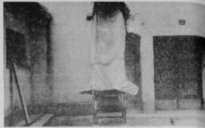
Nič kaj laskavo pa ni tale namestitev dvigala za dvigovanje vreč moka. Dvigalo ni zaščiteno, da ga zavarujejo pred dežjem, ga pokrijejo kar polivinilom.
