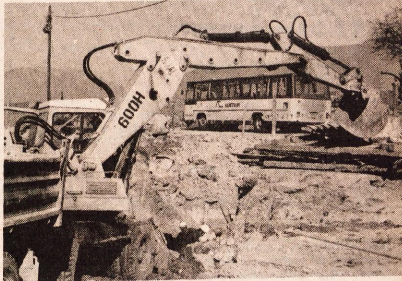
KRANJ — V soboto, 20. oktobra, so gradbeni stroji KOGP Tozd Gradnje zasekali v betonske plošče magistralne ceste na Zlatem polju. Gradnja rajonskega zbiralnika za odpadno vodo od Centra za usmerjeno izobraževanje proti Savi je namreč že prišla do magistralne ceste. V manj kot tednu dni — do četrta — bo tudi del kanalizacije, ki pelje čez magistralno cesto, že položen in zasut v globini okoli šestih metrov. Izkop in polaganje ogromnih cementnih cevi se bo nato premaknilo na nagnjeni teren vse do nabrežja Save, kjer se bo kanalizacija priključila na začasni zbirni kanal. — L. M. — Foto: F. Perdan
