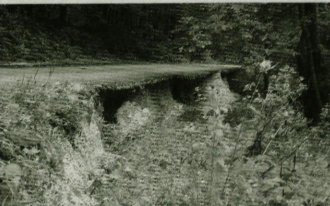
Cestni usad v dolžini 40 metrov na odcepu ceste Snovik-Bela Peč (foto: Bojan Klemen).
