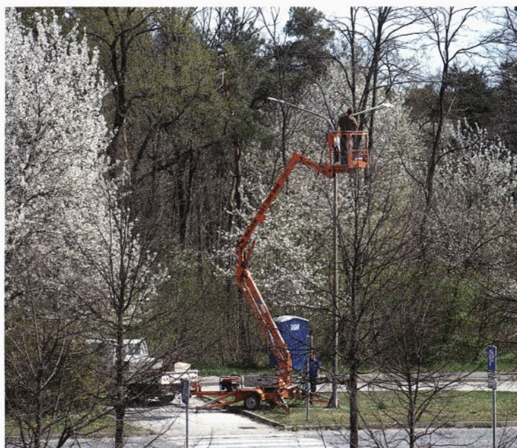
Montaža javne razsvetljave
