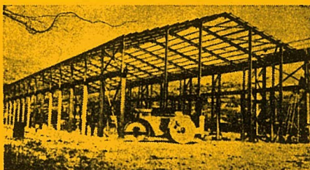
OBJEKAT RADEN PO TIPSKOJ KONSTRUKCIJI OBJEKT NACH DER TYPENKONSTRUKTION STRUCTURE MADE OF PREFABRICATED STRUCTURAL ELEMENTS
