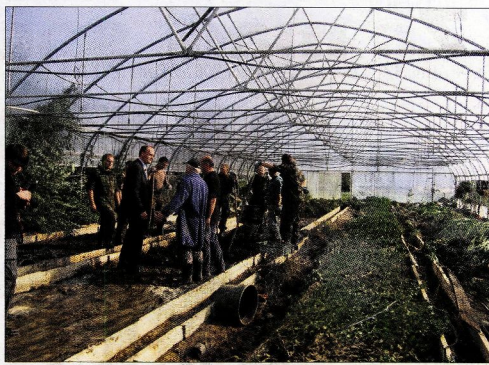
Po ogledu trgovsko-poslovnega kompleksa, poplavljenih hiš ob Hudinji ter povsem uničenega vrtnarstva Krašovec in Arčlino je minister odšel še na ogled Laškega.
