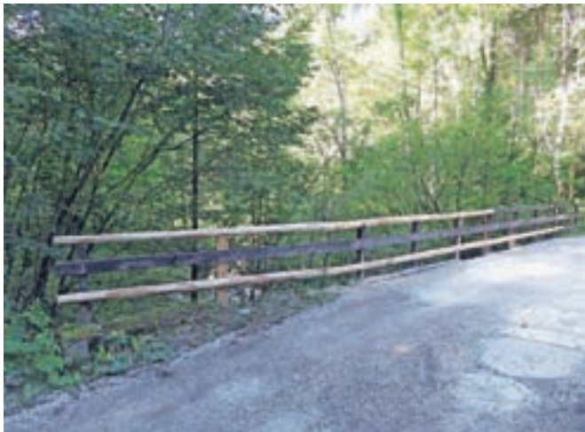
Popravljen ograja na mostu pri Jurju / FOTO: BOJAN POLLAK
