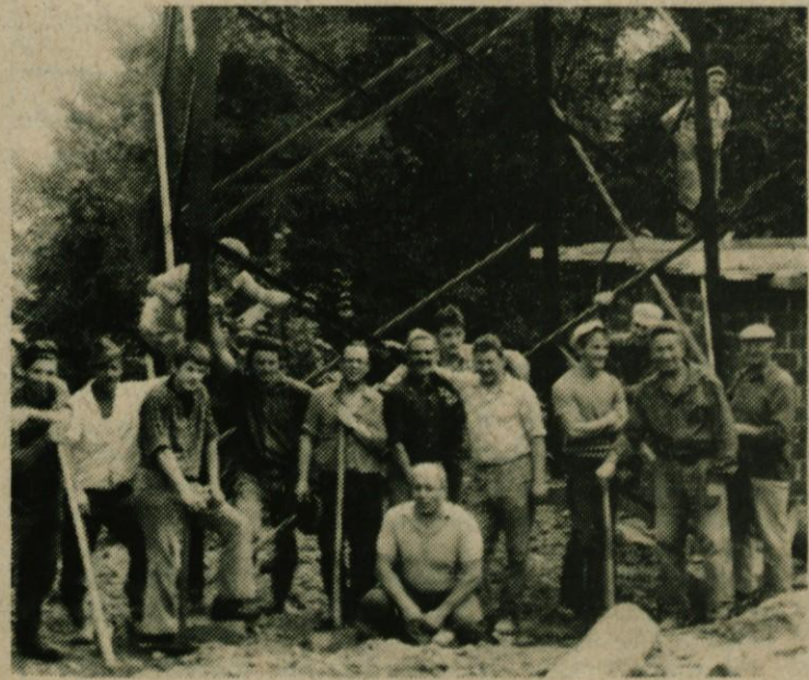
Pridni lažanski in planinski prostovoljci na gradbišču pretvornika na Starem gradu
