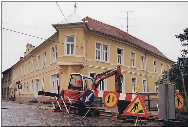
Del Potrčeve je gradbišče. Foto: Črtomir Goznik
