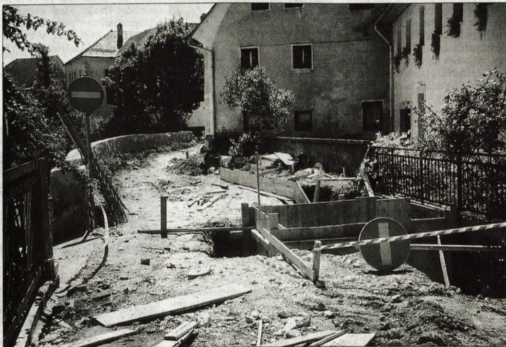
Križišče Gubčeve in Trubarjeve ulice in zid, ki ga bodo pilotirali.
