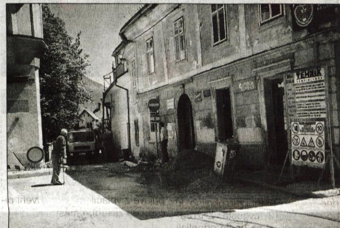
Dela na začetku Gubčeve ulice.
