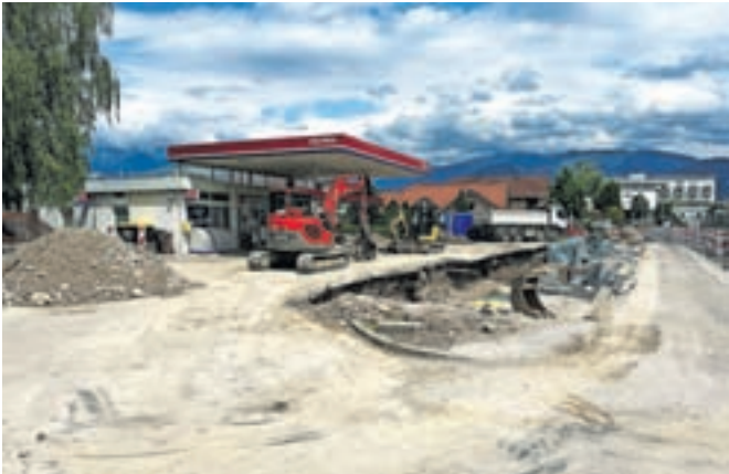
Prenova bencinskega servisa na Ljubljanski cesti
