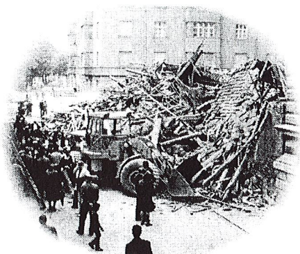
Rušenje stavbe na Orožnovi 15. maja 1981 ob 12.30, kjer bo stala nova stavba UKM
