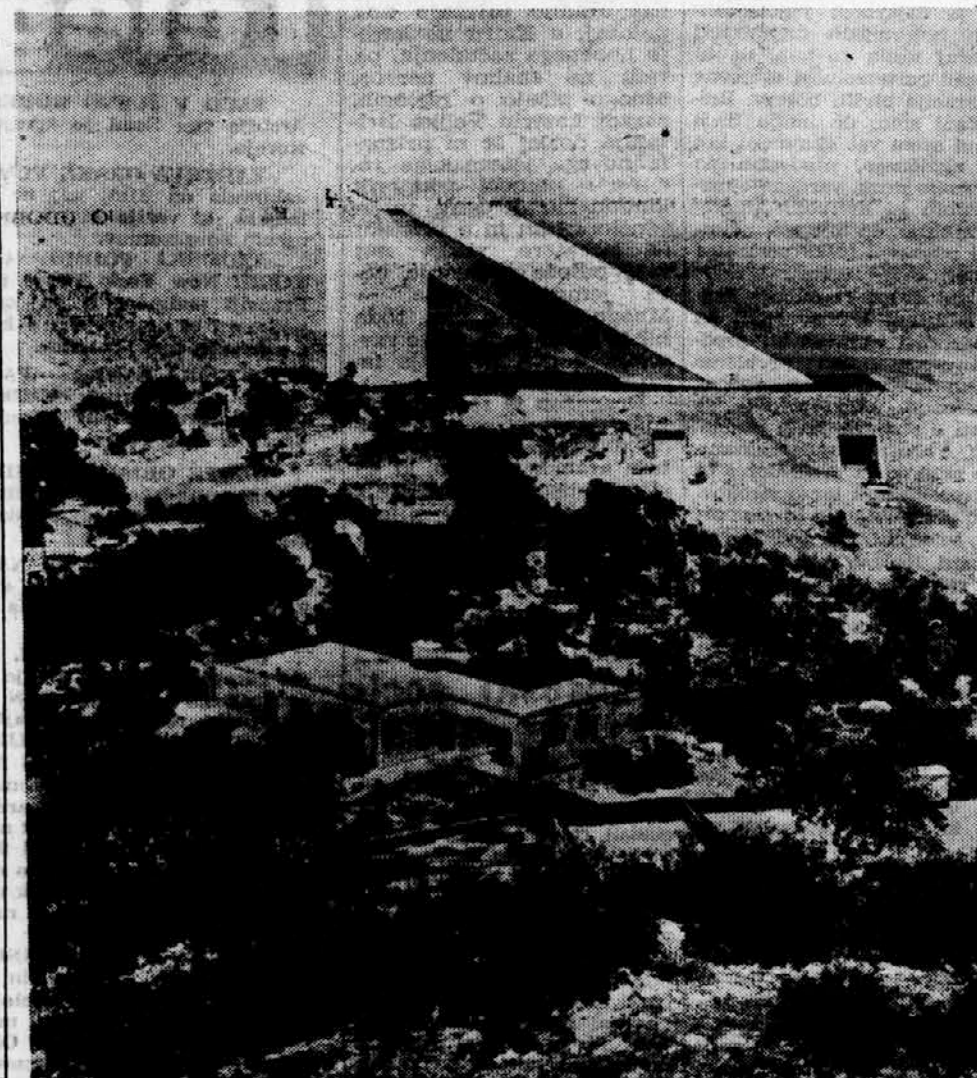
Na hribu blizu Tucsona v južnem delu Arizone gradijo teleskop, ki naj bi zbral nove podatke o Soncu, središču našega planetarnega sistema. Okoli 160 m dolge ogrode bo postavljeno tako, da bo pognano sredi v njem spremijalo Sonce od vzhoda do zahoda. Zgoraj del črni stoln na 33,5 m visokem stolpu, katerega stene so debele 76 cm, da bo kar najmanj tleslajev. Posebno središču s premerom 168 cm bo vrglo podoba Sonca v podzemeljske prostore, od koder jo bo drugo ogledalo vrnilo v pritličje, kjer jo bo tretje poslalo v valjaste cisterne, kjer bo spektograf odkrival značilnosti sončnih peg in drugih pojavov na sončni površini.
