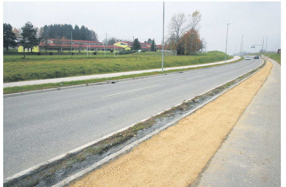
Gradnja pločnika naj bi bila končana te dni.
