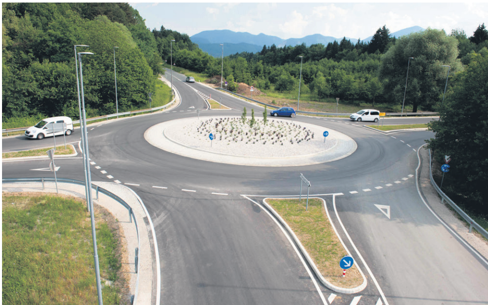
Voc je letos na Celjskem zgradil tudi več krožišč. Na fotografiji krožišče Arja vas-Žalec.
