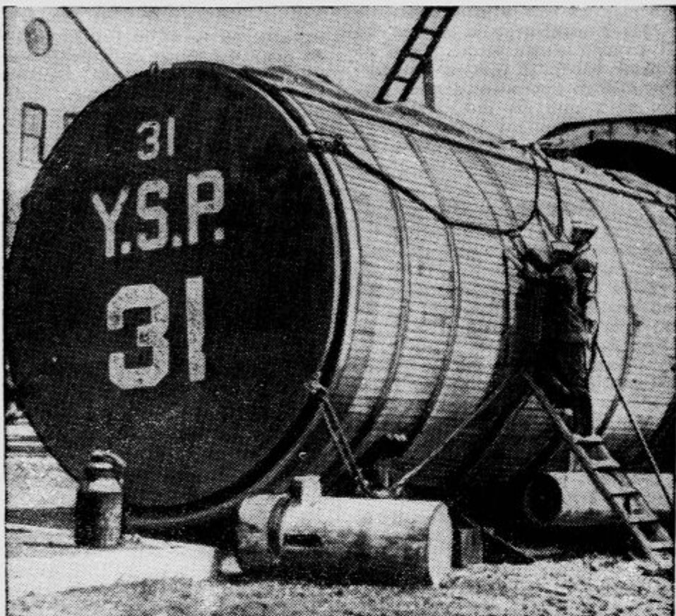
En izmed šestih ogromnih pontonov v ameriškem pristanišču Portsmouthu, s katerimi bodo dvignili potopljeno podmornico »Squalus«
