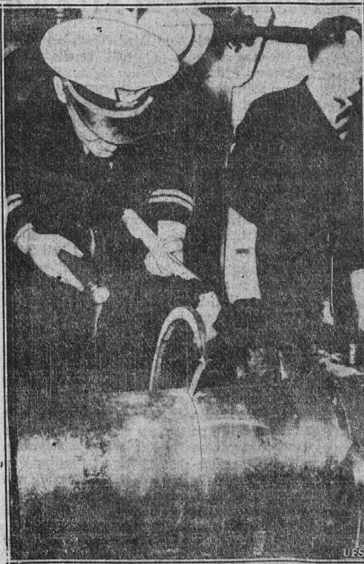
Ko je ameriška vladna dala zaseči nemške in italijanske ladje v tujakih pristaniščih, se je ugotovilo, da je moštvo na nekaterih takih ladjah napravilo škodo, da napravi ladje nerabne. Gornja slika kaže, kako so našli prežagano propellersko ost z žago se v zarez.
