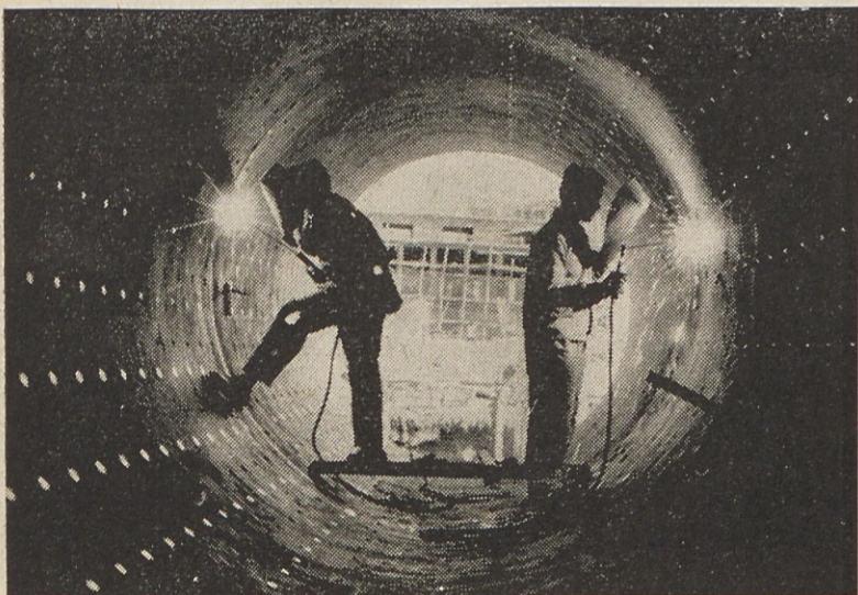
Varjenje mlina surovin na gradbišču cementarne Cherrapunji (Assam, Indija)
