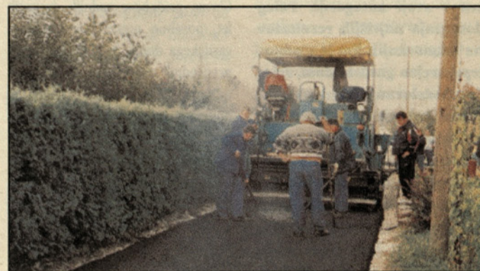
Asfaltiranje ene izmed ulic v Dolenji vasi, pod katero je že položen kanalizacijski vod.
