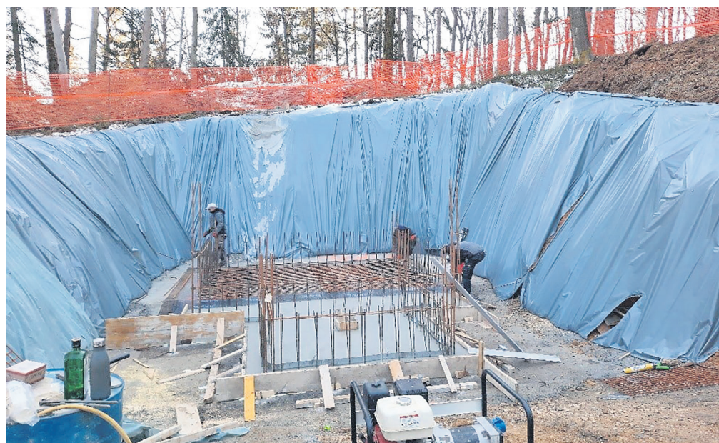
V sklopu gradnje vodovoda izvajalec gradi tudi vodohran Zahum. (Foto: Občina Laško)
